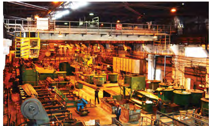
Шаропрокатный стан ДМПЗ. Общий вид
