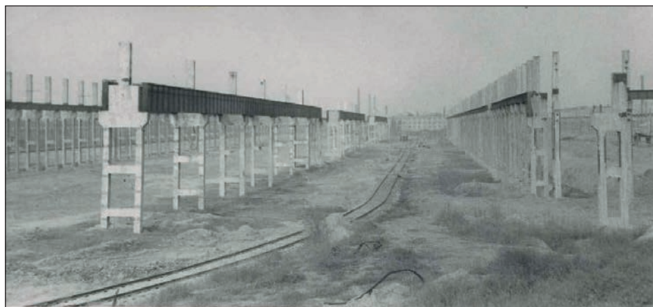
Строительство пролетов цеха, 1968 г.
