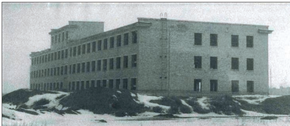
Строительство АБК ТПЦ 7
