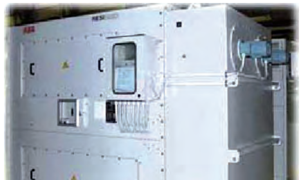
Рис. 4. Трансформатор з повітряно-водяним охолодженням IP 54 виконаний для потреб гірничої промисловості
