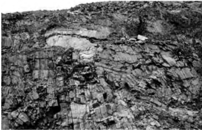
Рис. 1. Кар'єр ПівдГЗК, північно-східний борт. Складки з перекинутим заляганням крил, горизонт –15 м
