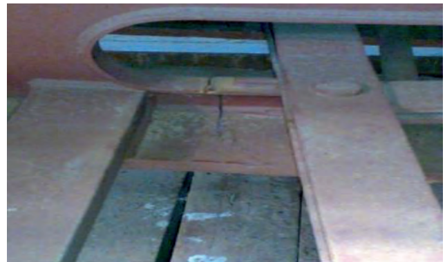
Тріщина в хребтовій балці довгобазного вагона-платформи
