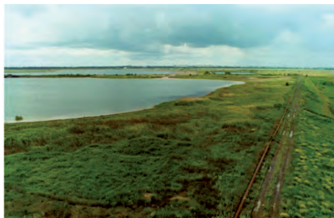
Рис. 2. Загальний вид діючого хвостосховища в балці «Щербаківська» зі складування відходів гідрометалургійної первинної переробки уранових руд
