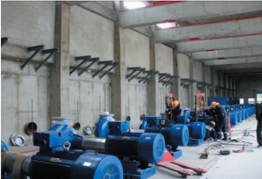
Рис. 3. Монтаж оборудования комплекса водоподготовки
