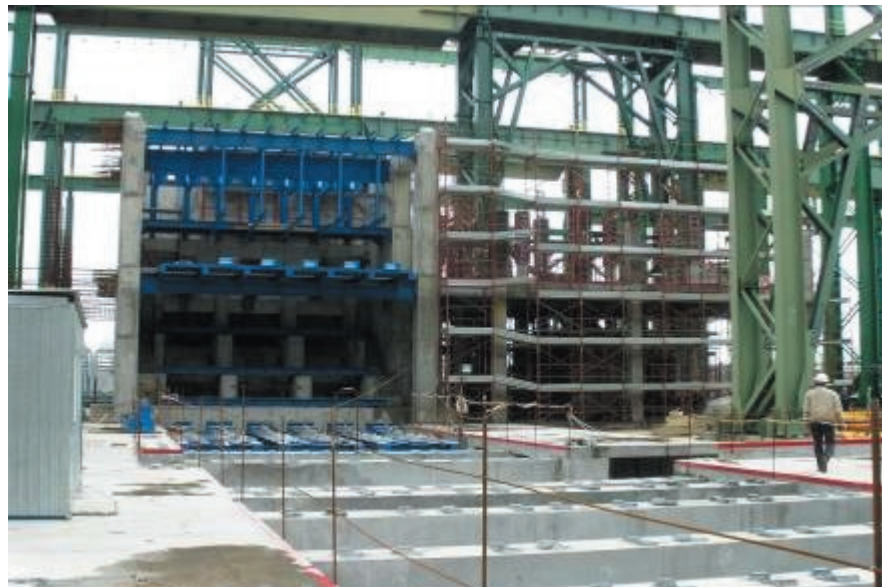
Рис. 2. Монтаж металлоконструкций на МНЛЗ № 1
