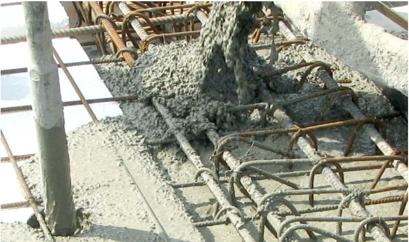
Рис. 1. Укладка бетонной смеси при использовании легких вкладышей в виде призм из экструдированного пенополистирола.
