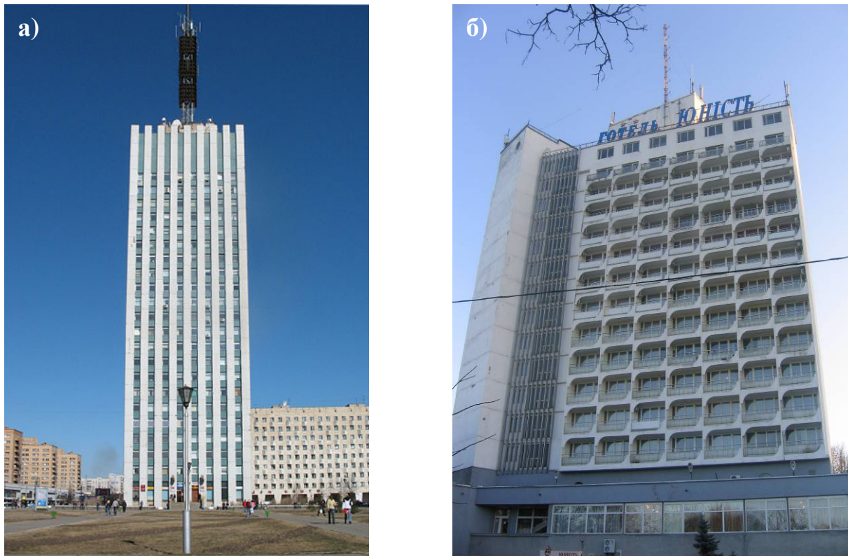
Рис.1.1. Расположение антенных опор на кровле высотных зданий: а) г. Архангельск, пр-т Чумбарого-Лучинского б) г. Одесса, ул. С. Варламова, 32, гостиница Юность.
