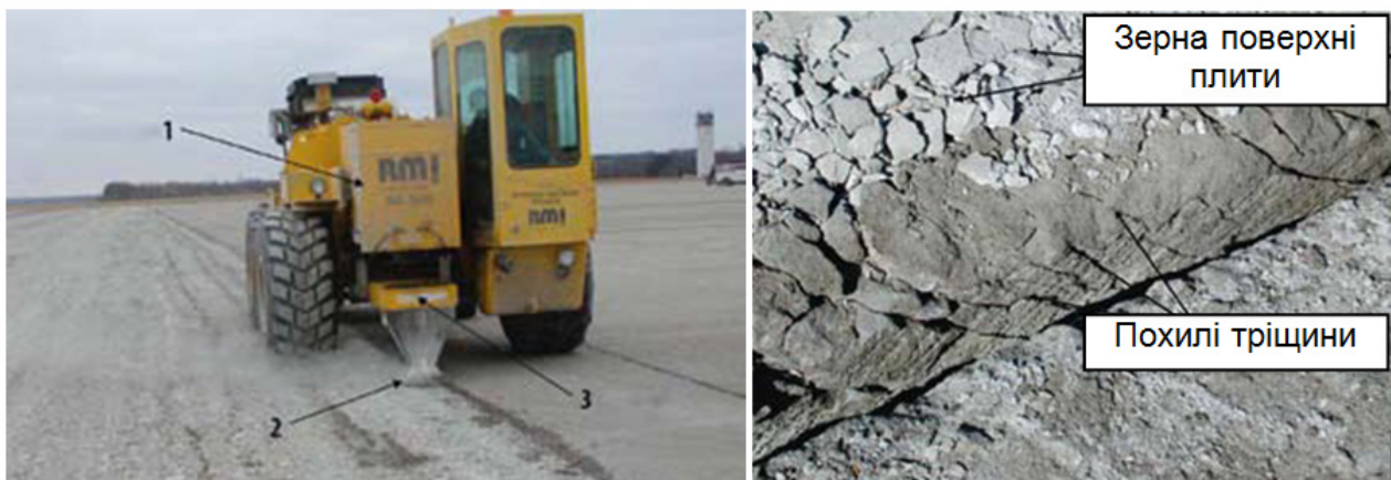
1 — противаги масою від 5,5 до 9 т; 2 — головка, що передає навантаження на покриття через підшву розміром від 200 до 250 мм; 3 — резонансна стальна балка довжиною 3,8 м
