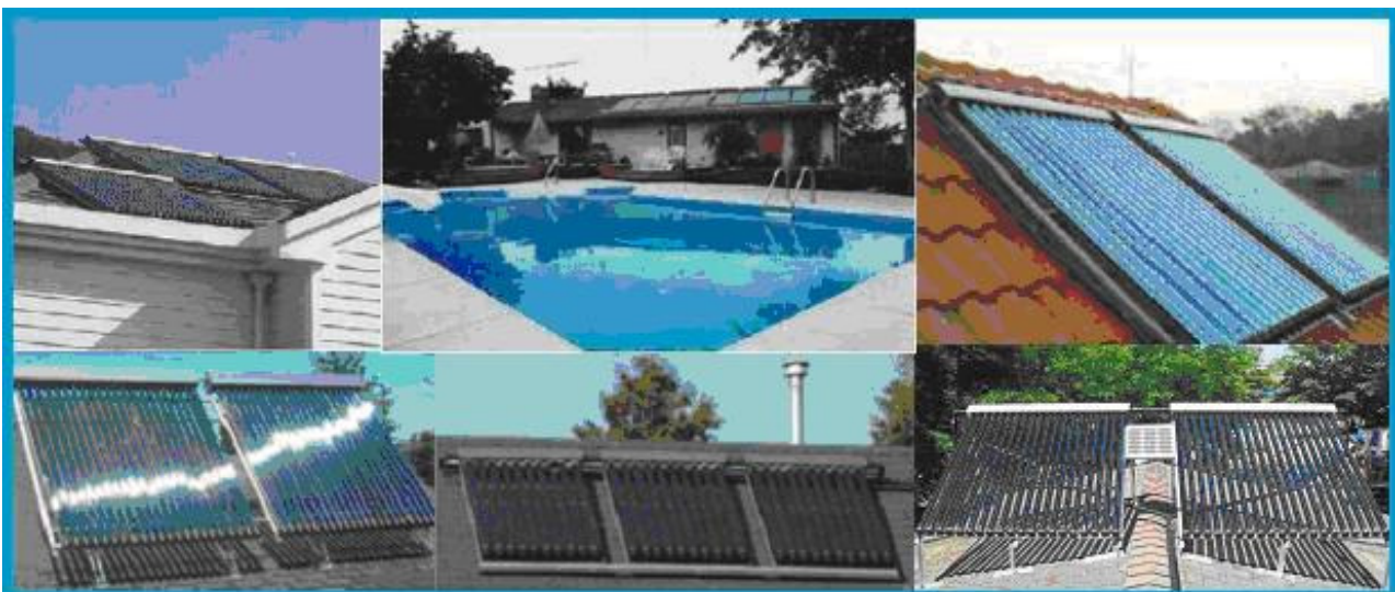
Рис.6 Приклади монтажу колекторів на різних типах покрівлі та в різних виконаннях по кількості та кутами нахилу
