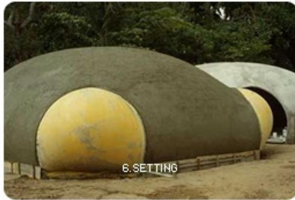
Рис 6. Тужавлення бетону
