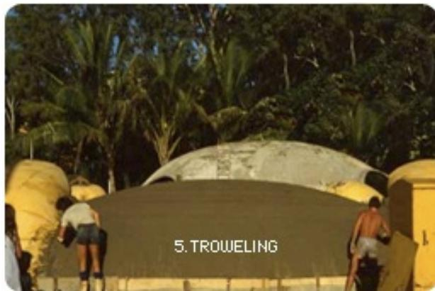
Рис. 5. Розгладжування бетону кельмою
