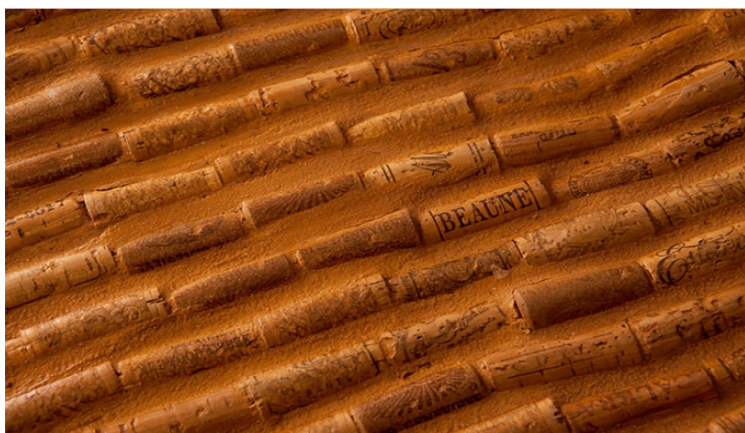
Рис. 1. Підлога з винних пробок
