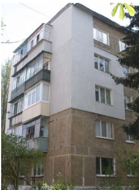
Рис. 2. Утеплення будинків у м. Полтава.
