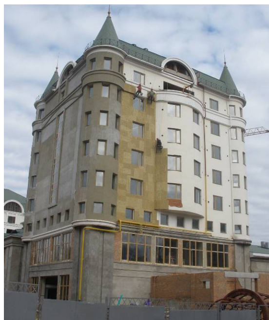
Рис. 2. Утеплення будинків у м. Полтава.
