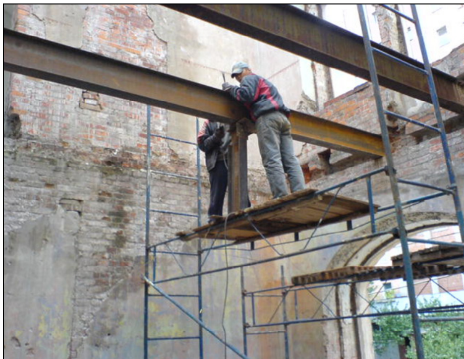
Рис.1. Схема установки металлической балки с использованием ручных лебедок
