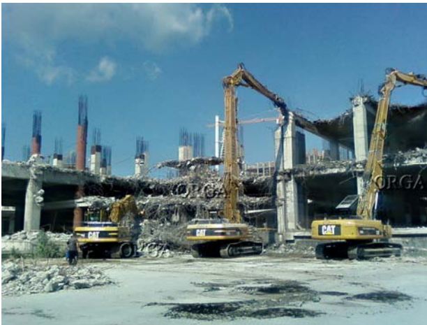
Рис. 4. Спеціальна техніка для проведення демонтажу складної конструкції біля НСК
