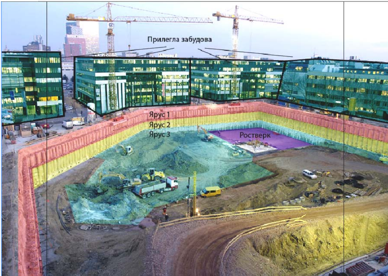
Рис. 2. Спорудження блоку G торговельно-розважального центру Euro Plaza з офісними приміщеннями різної поверховості (4 - 8 поверхів) та трьохрівневим підземним паркінгом в безпосередній близькості з існуючими будинками, Відень, Австрія.2006-2008 р
