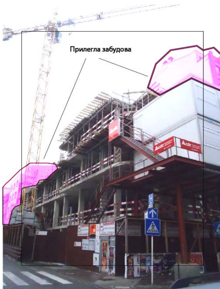
Рис.3. Спорудження шести-поверхового житлового будинку. Люксембург, 2009-2010 р
