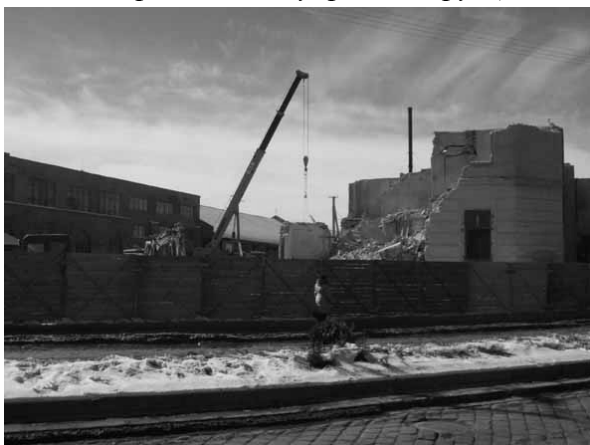
Початок першого етапу реконструкції
