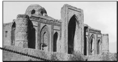
Общий вид здания при реконструкции.
