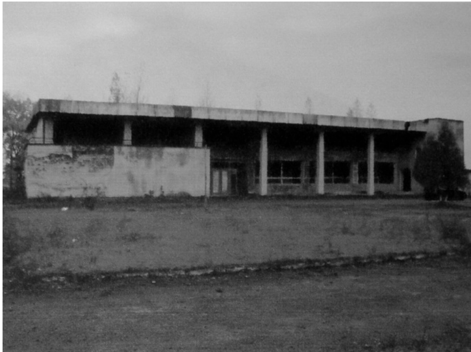
Рис. 7. Стан будівлі клубу в с. Молотків Лановецького району Тернопільської області на 2007 р.
