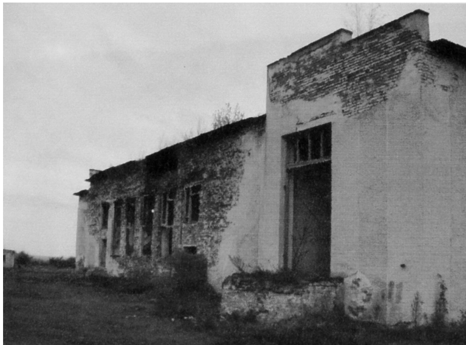
Рис. 9. Стан будівлі клубу в с. Молотків Лановецького району Тернопільської області на 2007 р.
