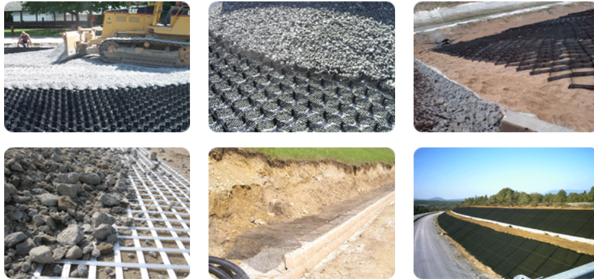
Рис.1 Приклади використання геосинтетичних матеріалів.
