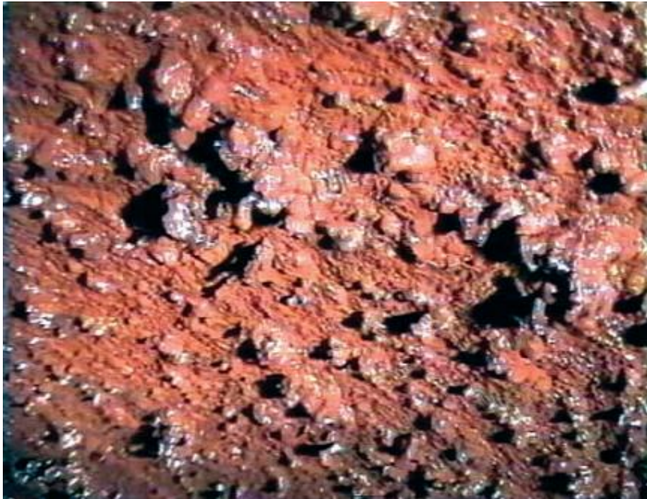
Рис. 4 – Характер макрошероховатости внутренней поверхности водовода диаметром 1200 мм (время эксплуатации водовода 37 лет).
