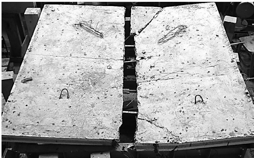
Рис.5 - Характер руйнування плити.
