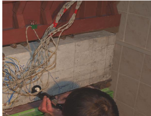
Рис. 5. Выявление образования и измерение ширины раскрытия трещин с помощью микроскопа МПБ-2 с 24-х кратным увеличением
