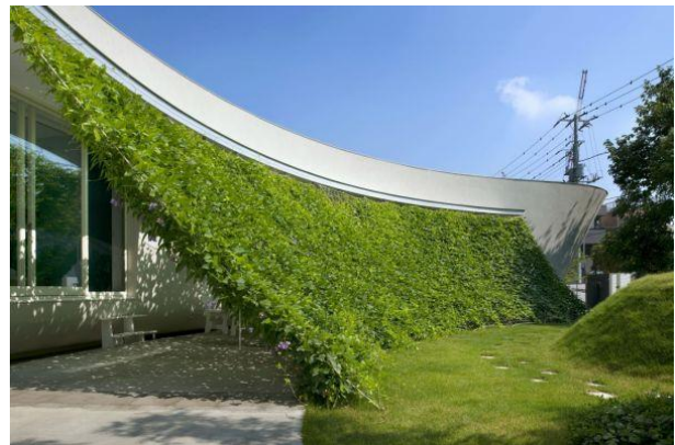
Рис. 4. Житловий будинок Green Screen House, арх. Hideo Kumaki Architect Office, м. Сайтама, Японія
