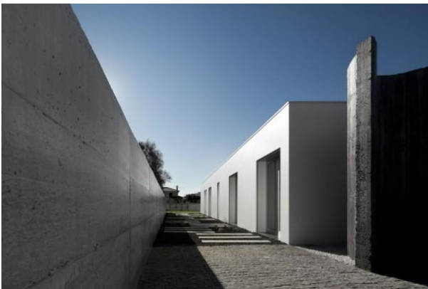
Рис. 3. Житловий будинок Xieira House II, арх. A2 + Arquitectos, поблизу м. Лейрія, Португалія
