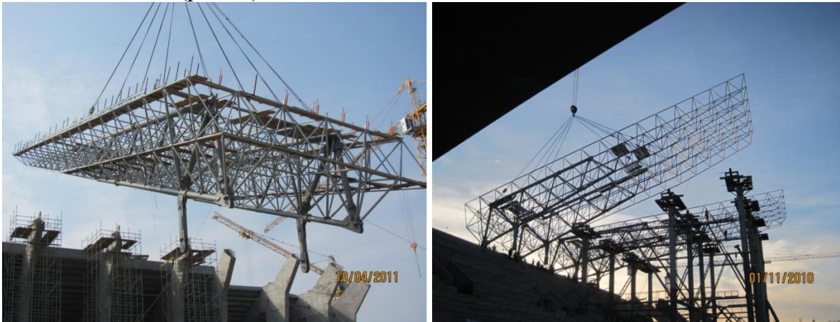
Рис. 4. Монтаж секцій покриття
