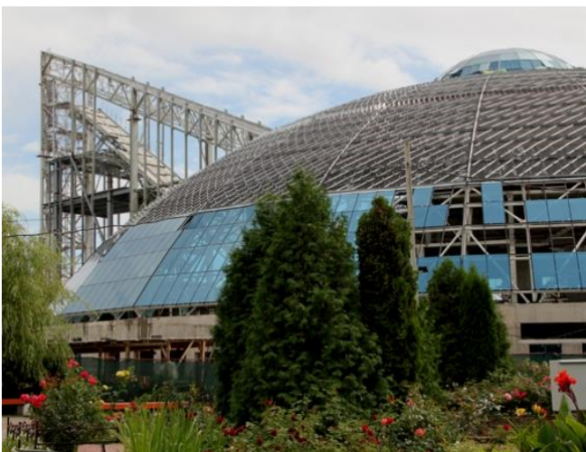
Рис.4. Конструкції купола на стадії монтажу покриття
