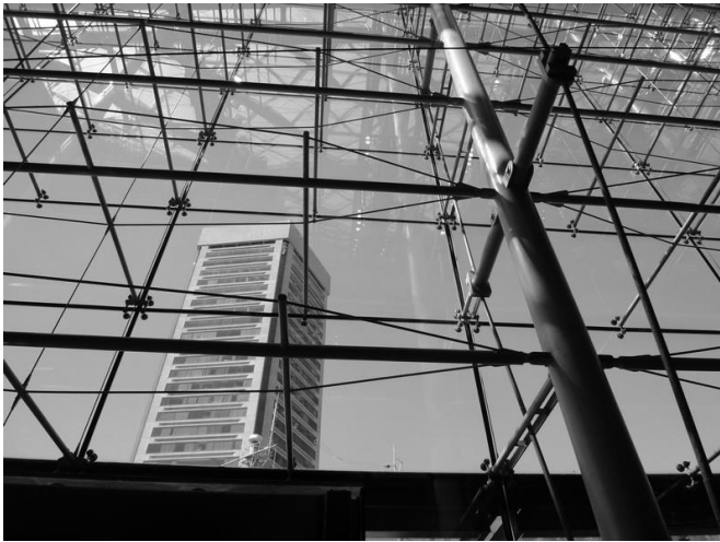
Рис. 3. Кріплення спайдера до вантової системи
