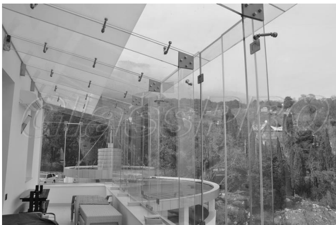
Рис. 4. Кріплення спайдера скляних ребер
