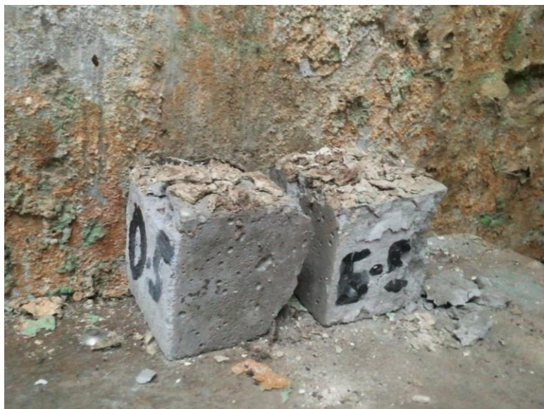
Рис. 1 – Біопошкодження в жилі приміщенні
