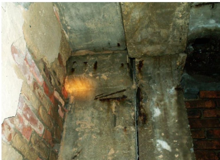
Рис. 2. Біопшкодження в виробничому приміщенні
