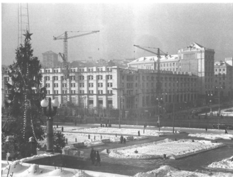
(1950-е годы. Строительство Почтамта, г. Киев)
