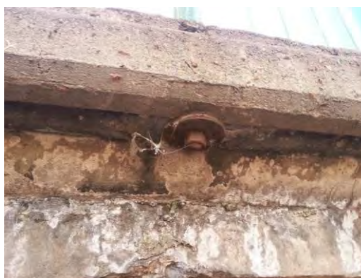
Rys. 13-14. Żeliwne słupki - pozostałości oryginalnej balustrady
