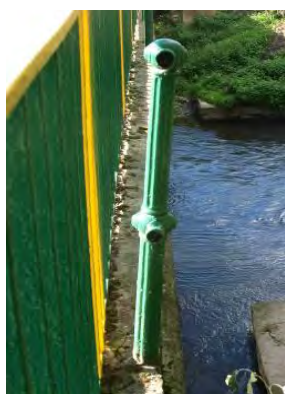
Rys. 13-14. Żeliwne słupki - pozostałości oryginalnej balustrady
