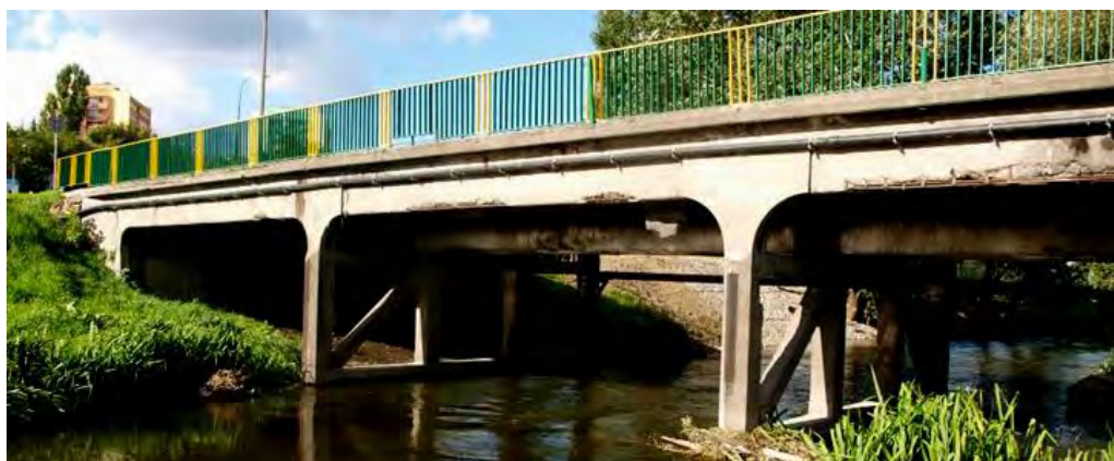
Rys. 1. Widok mostu na Kalinowszczyźnie od napływu; stan - 2013 r.
