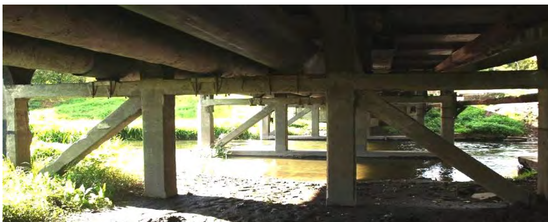
Rys. 8. Filary mostu na Kalinowszczyźnie
