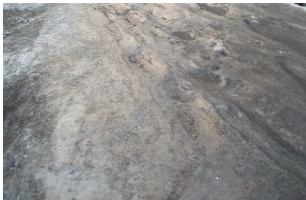
Рис.5 Поверхня дорожнього покриття посипана гарячим гранітним відсівом
