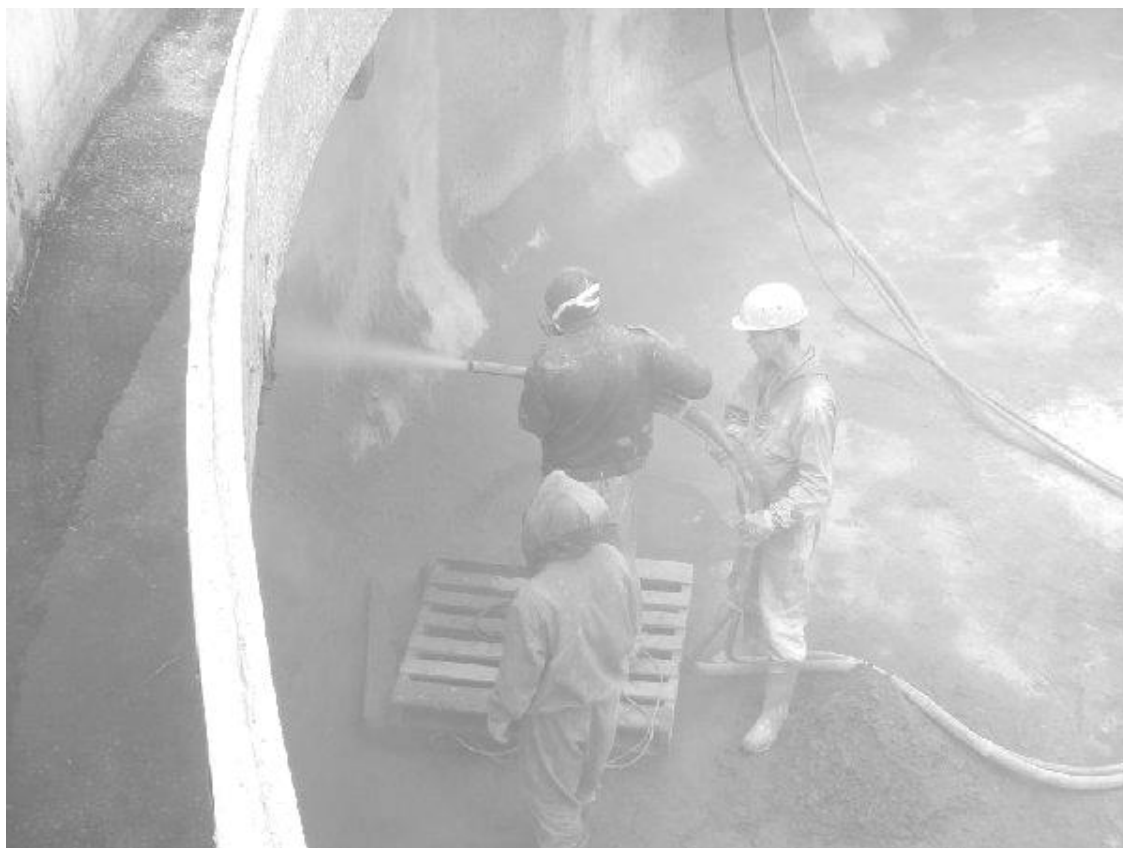
Рис. 1. Нанесення торкретбетону на внутрішню частину стінки циліндричного залізобетонного резервуару
