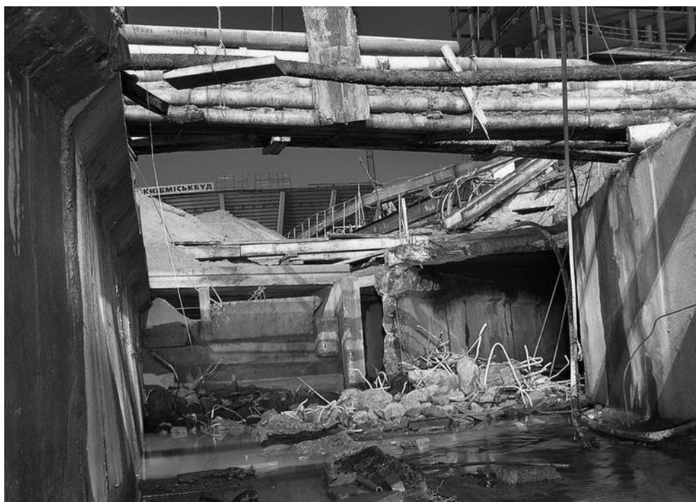
Рис.4 Перенос Прозоровского коллектора при реконструкции НСК «Олимпийский» г. Киев.
