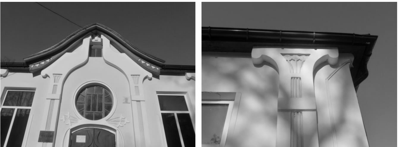
Рис. 2. Елементи фасаду будинку по вул. Лідова, 6 (фото М. Белінської 2016 р.)
