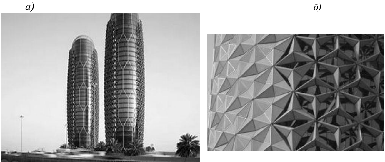
Рис. 1. Al Bahar Towers в Абу-Дабі (ОАЕ). а). Загальний вигляд хмарочосів ; б). Рухомі сонцезахисні елементи фасадів .
