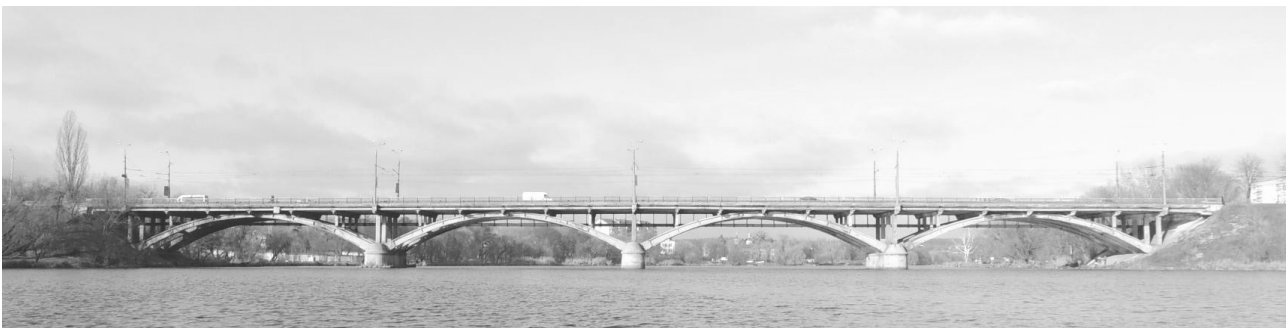
Рис. 1 – Загальний вид мосту по вул. В. Чорновола
