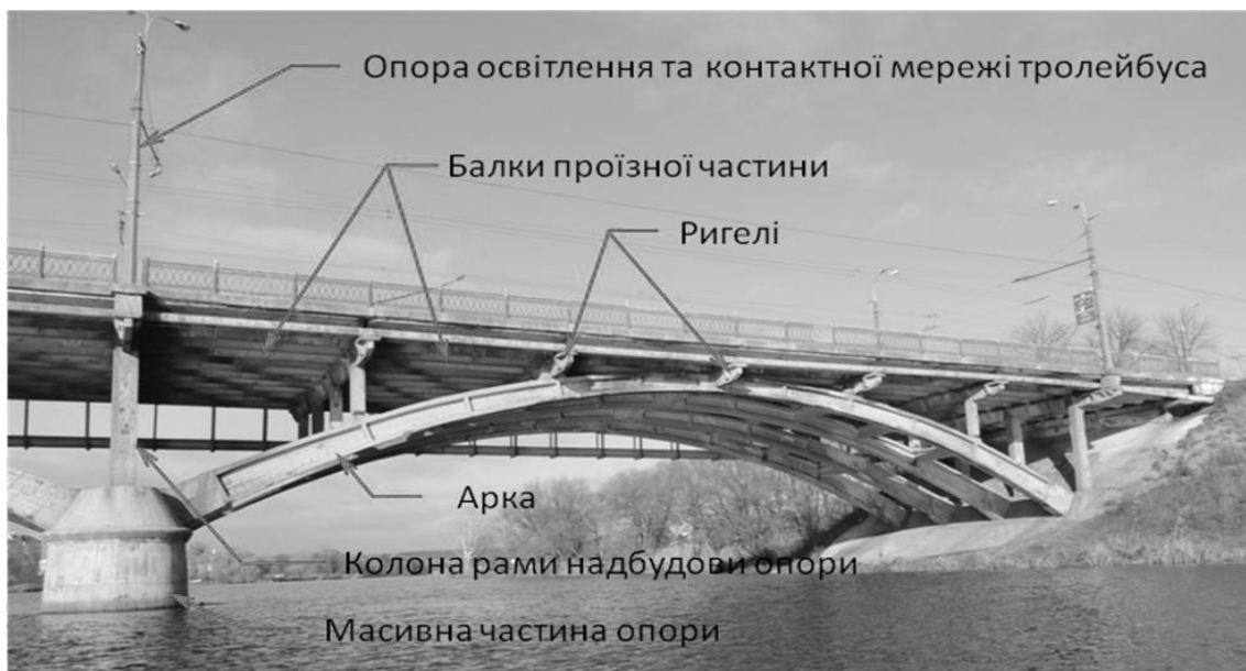
Рис. 2 – Загальний вид конструкцій арочної прогонової будови мосту по вул. В. Чорновола
