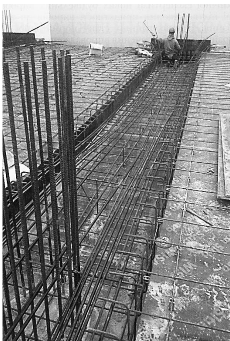
Рис.3. Встановлення канатів для постнапруження балки монолітного перекриття
