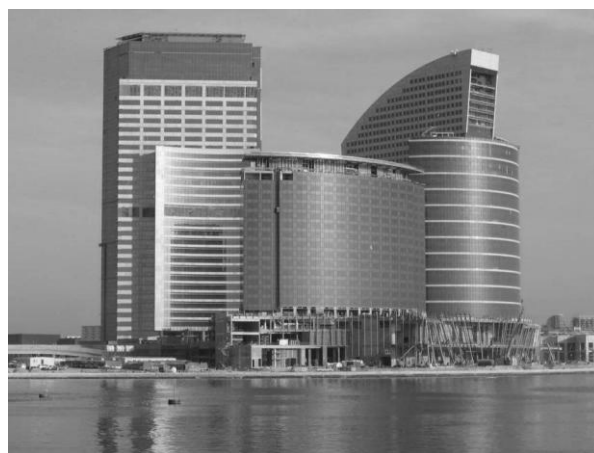
Рис.2. Застосування постнапруження за технологією фірми VSL. Дубай, ОАЕ (фестивальне містечко). Загальна площа постнапруження 250 тис.м 2
