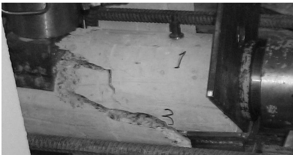
Рис. 2. Руйнування колони з попередніми обтисненням за похилим перерізом.
