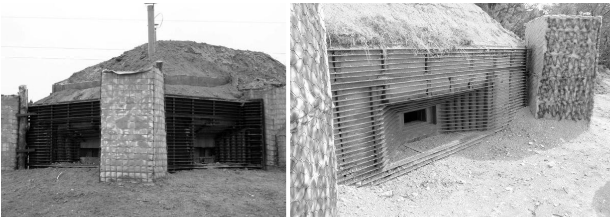
Рис. 10. Реалізовані вогневі споруди ВОП згідно покращеного проекту
