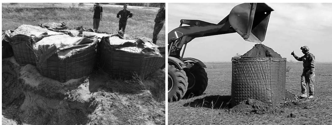
Рис.5. Проведення натурних випробувань (три осколково-фугасні 100мм і два кумулятивні влучення 70мм) та спорудження рубежів із габіонів в зоні АТО
