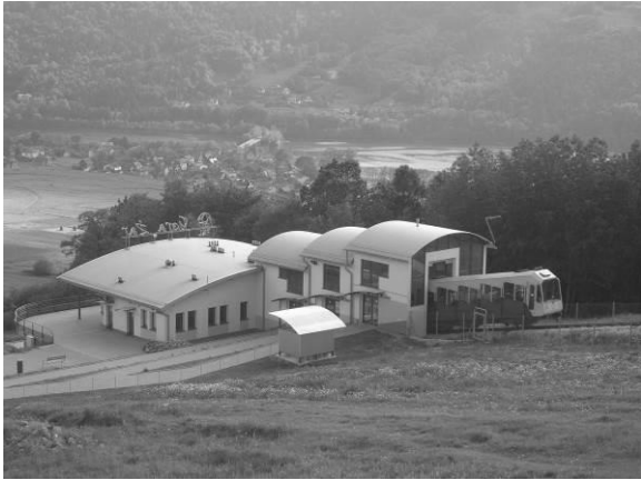
Рис.15. Нижня станція фунікулера на г. Жар у Межиброді Живецькім. Польща. Фото [10].
