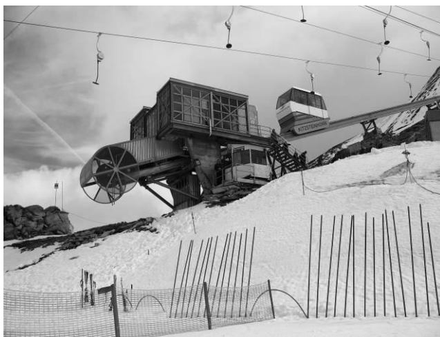
Рис. 17. Нижня станція фунікулера на г. Кітцштайнгорн у Тиролі, Австрія.
