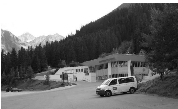
Рис. 19. Нижня станція фунікулера у Пітцталі, Тироль, Австрія.
