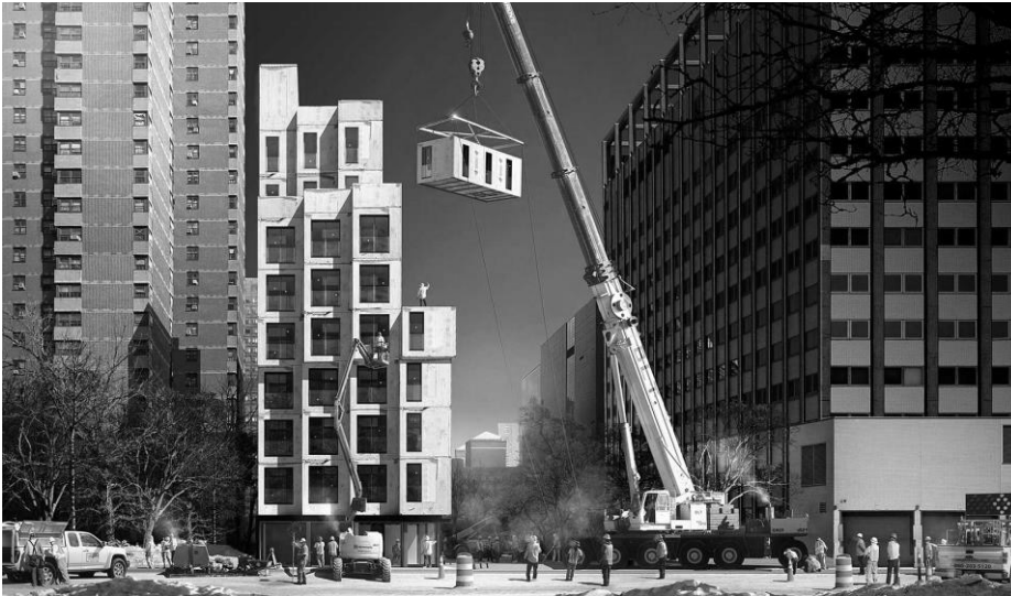
Рис. 3. Експериментальна будівля мікроапартаментів, бюро nArchitects , Нью- Йорк.
