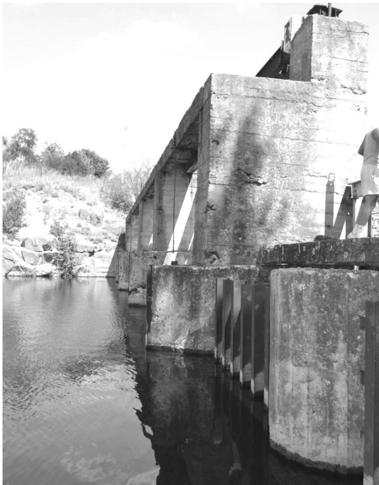
Рис. 2. Масивні залізобетонні конструкції Островецької МГЕС на р. Ятрань
