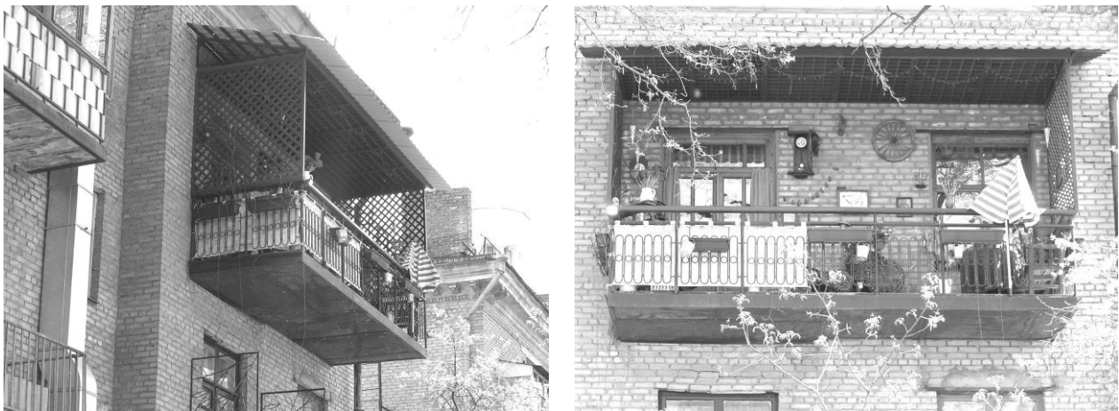
Рис. 1. Расширение проемов при реконструкции существующего балкона: а) вид сбоку; б) вид спереди.
