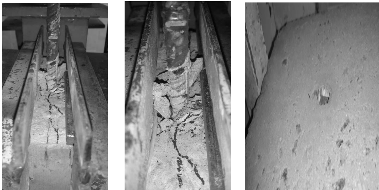
Рис. 1. Разрушение вследствие нарушения связей сцепления арматуры с бетоном: а – образец АН-V-75-3; б – образец АН-V-75-4
