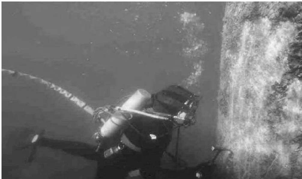
Рис. 2. Обстеження підводних частин опори під водою
