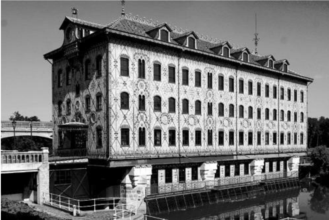
Рис. 4. Шоколадна фабрика «Меньє» у Франції (1871—1872, архітектор Же. Соньє, інженер Е. Мюллер). Фасад фабрики декоровано металевим фахверком, який, також, відіграє конструктивну функцію [5].
