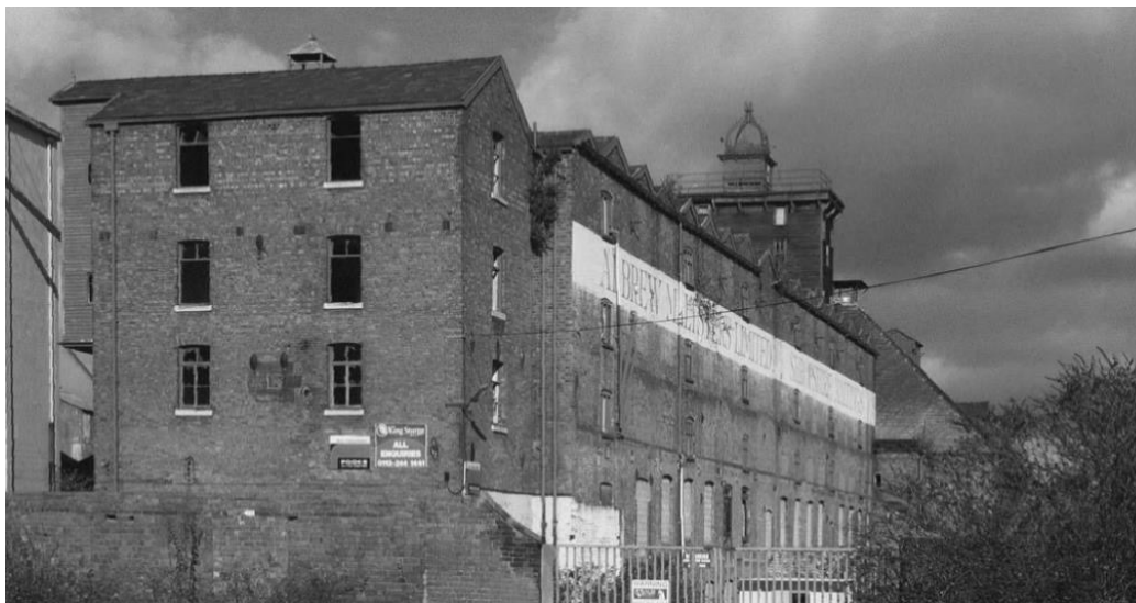
Рис. 2. Фабрика льону в Шрусберї (Велика Британія 1796 рік) – перша будівля з металевим каркасом [4].
