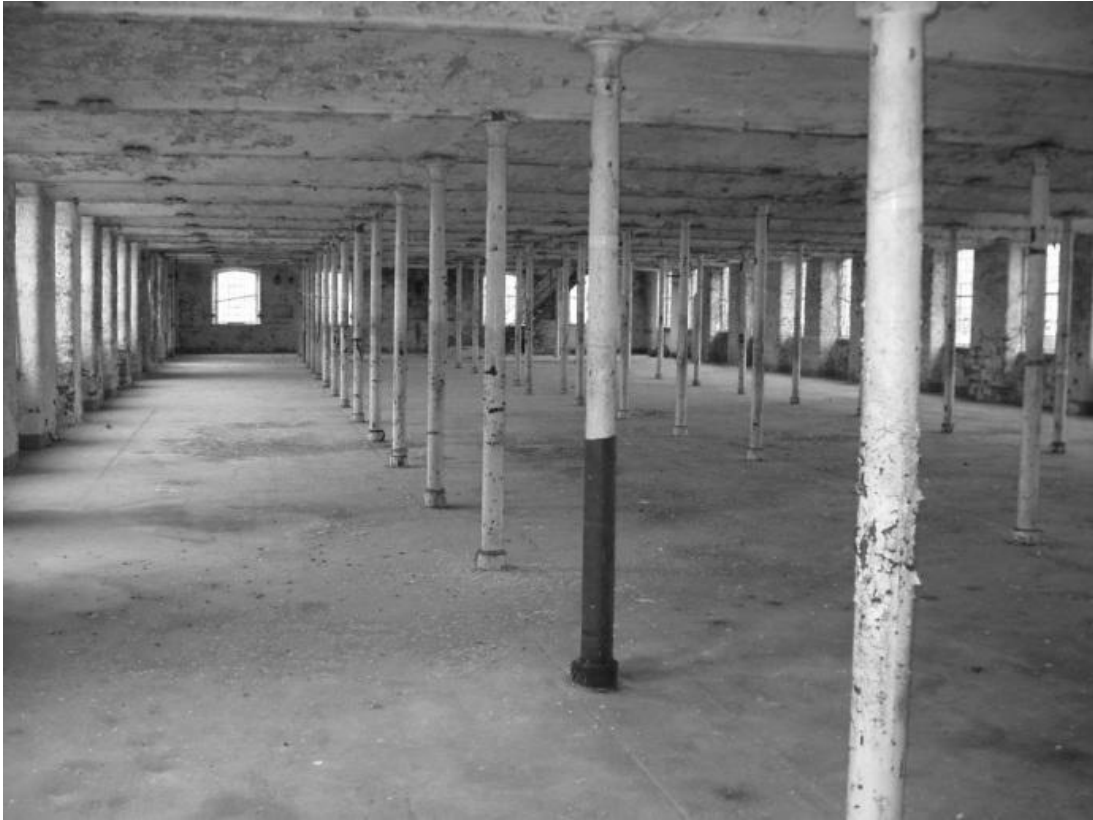
Рис. 3. Металевий каркас інтер'єру фабрики льону в Шрусбері [4].
