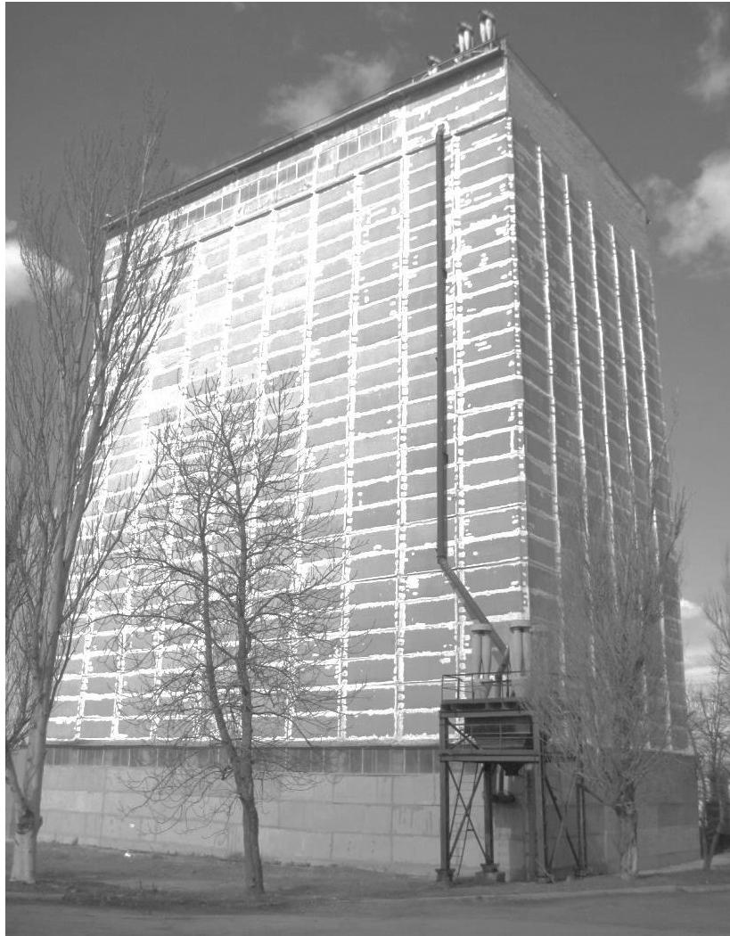
Рис. 1. Загальний вигляд елеватора силосного типу
