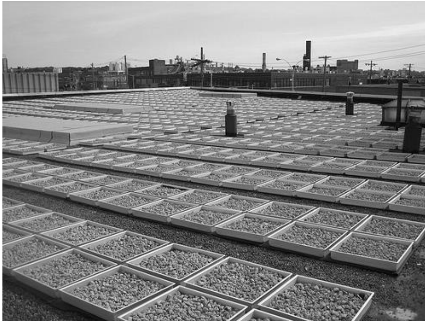
Рис. 2. Приклад «блакитного» («синього») покриття.
