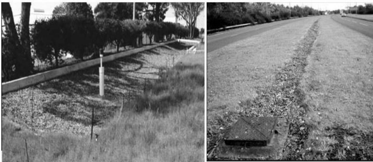
Рис. 2. Приклад інфільтраційної траншеї [3, 4].
